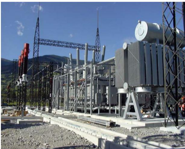
Bild: Montage des Phasenschiebertransformators im UW Tauern
